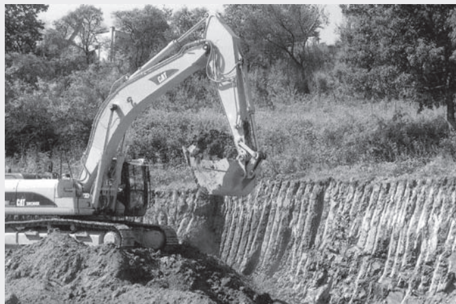
Hloubení stavební jámy.
