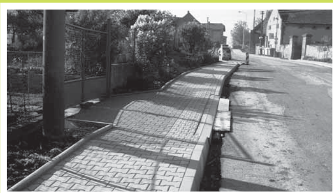
Realizace obdenných bezbariérových chodníků na jihu Čech.
