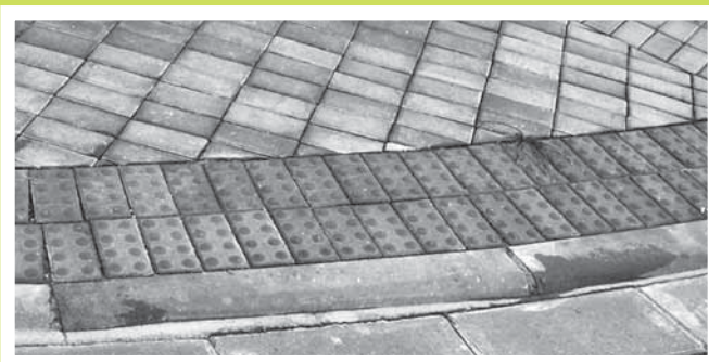
Dlažební kameny s nálsky v lici náslapné ploše - s označením slepecká, určená především pro vytvoření varovných pásů na chodnicích, pro osoby nevidomé a slabozraké.
