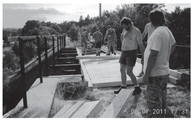
Přestavba drážního mostu.
