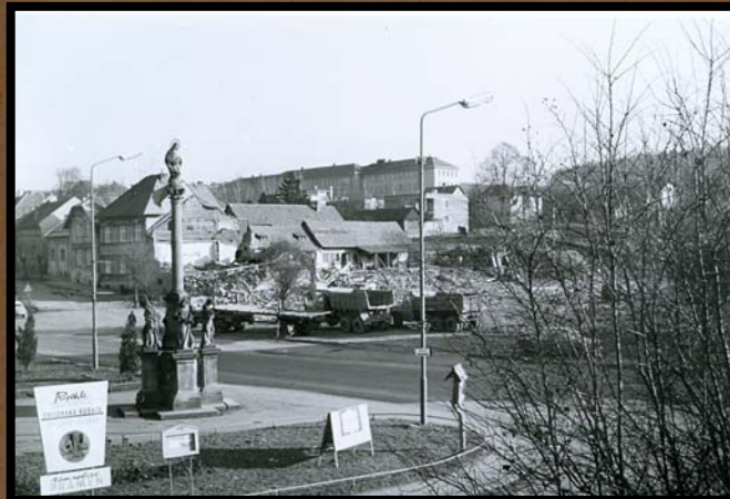
Z pěti domů jsou již jen rozvaliny.
