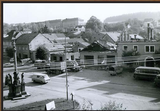
Demolice ve prospěch Vizovjanky.
