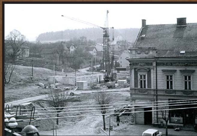
V pozadí roste první panelový dům..
